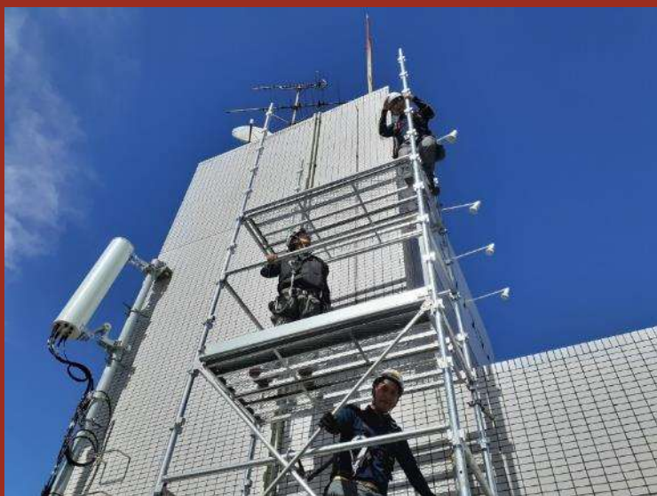
足場構築作業中の一コマ
