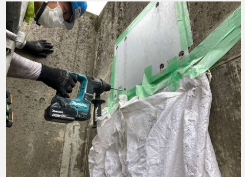
ケミカルアンカー打設
