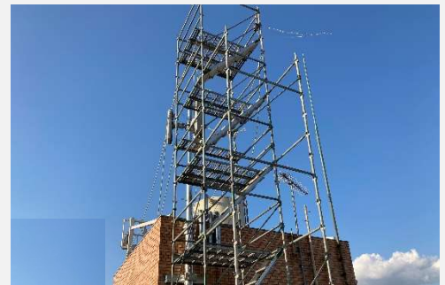
支持柱設置工事
