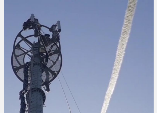
アンテナ交換
